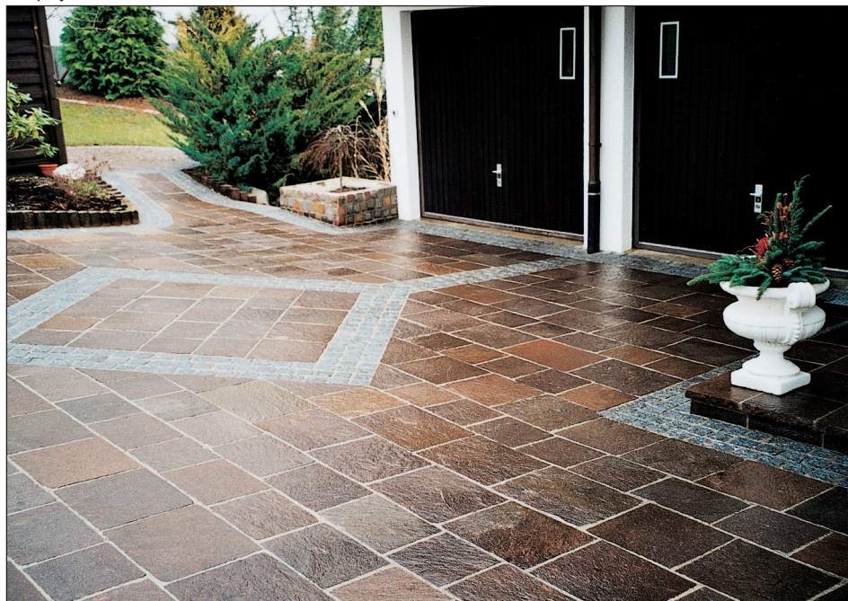
Porphyr-Platten in Bahnen mit Granit-Pflaster 9/11
